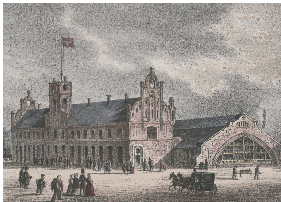
Østbanehallens opprinnelige stasjonsbygg
