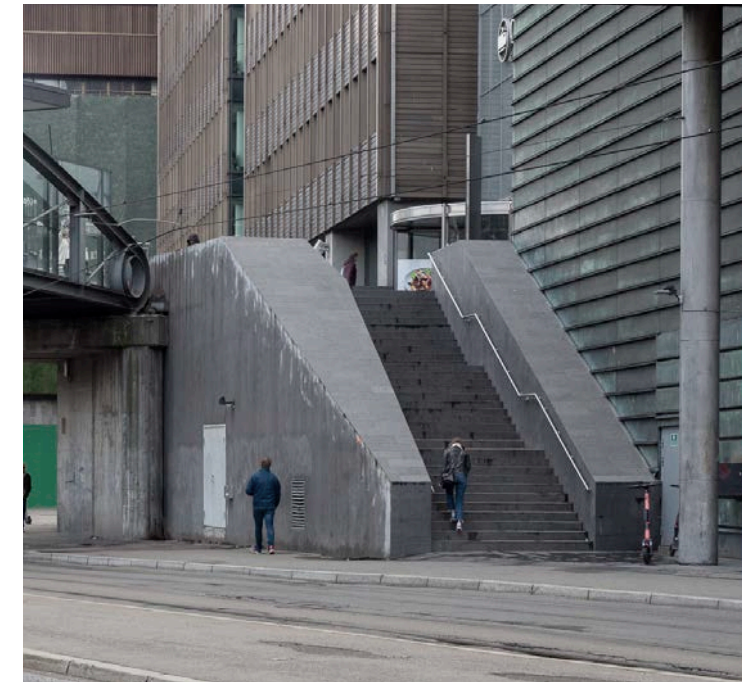
Lukket fasade: inngang kun på øverste nivå
